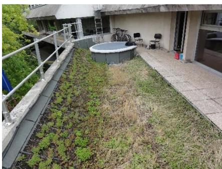
A défaut pour l'existant, **supprimer** les eaux résiduelles, **enlever** les débris, **nettoyer**, **repositionner** l'évacuation, **surélever** les points bas. En cas de stagnation d'eau sous les dalles de la terrasse, **pomper** l'eau à l'aide d'un aspirateur à eau, ou **traiter** régulièrement l'eau à l'aide de produits anti larvaires agréés ou à défaut avec du chlore.
